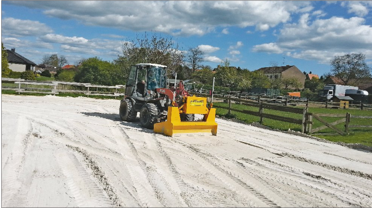
Wer die Technik hat, ist im Vorteil: Spezialisierte Sportplatzbauer besitzen moderne Geräte wie Blademaster. Foto: Haltern und Kaufmann
